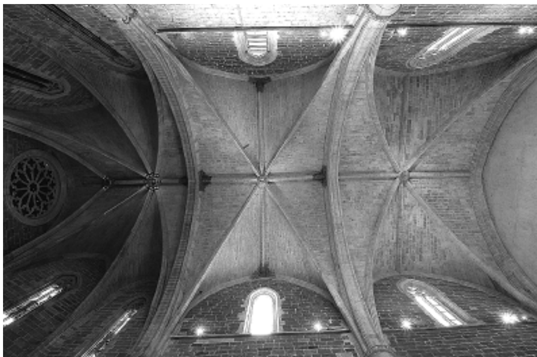
Bóveda de la iglesia arciprestal de Sant Mateu.
