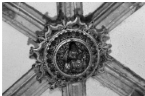
Clave de bóveda de la capilla de la pasión de la iglesia arciprestal de Sant Mateu.
